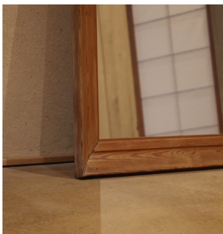
Finition enduit de sol
