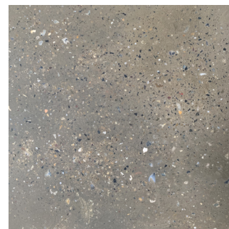
Chape poncée : surface lisse après traitement finition
