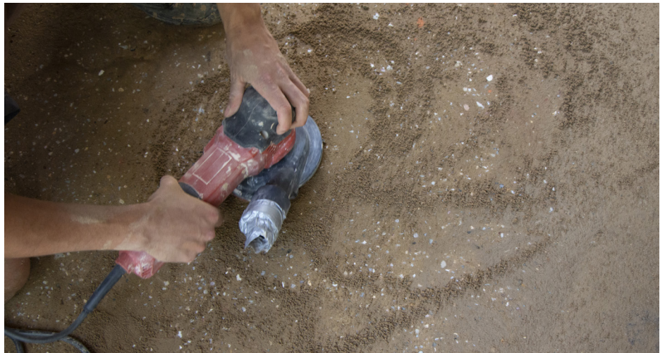
Ponçage à l'aide d'une ponceuse rotative diamantée
