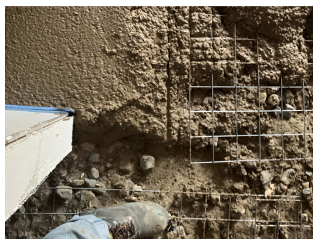
Mise en œuvre de la chape sur des armatures
