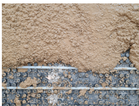
Mise en œuvre de la chape sur un panneau gaufré
