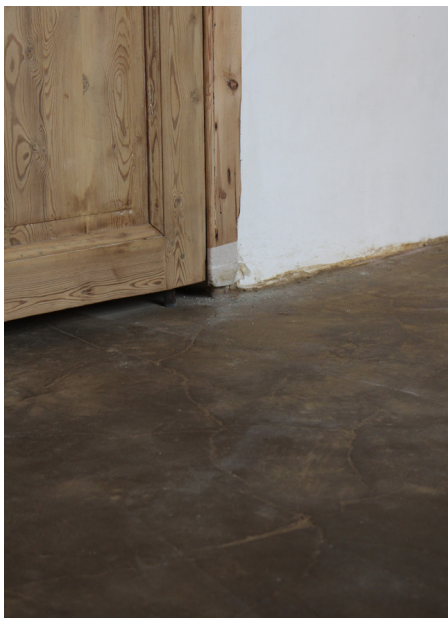
Finition à l'huile sur une chape lissée
