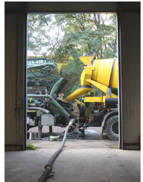
Mise en place du camion malaxeur sur chantier avec ou sans pompe à béton intégrée
