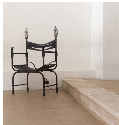
Finition lissée et cirée
