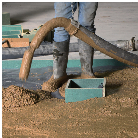
Coulage de la chape à l'aide du tuyau de la pompe à béton
