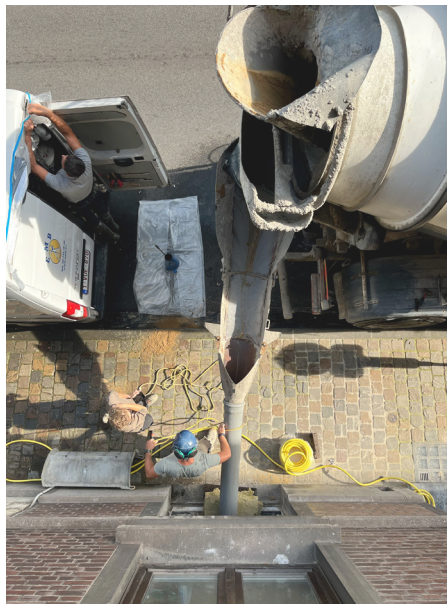
Mise en place du camion malaxeur sur chantier avec ou sans pompe à béton intégrée
