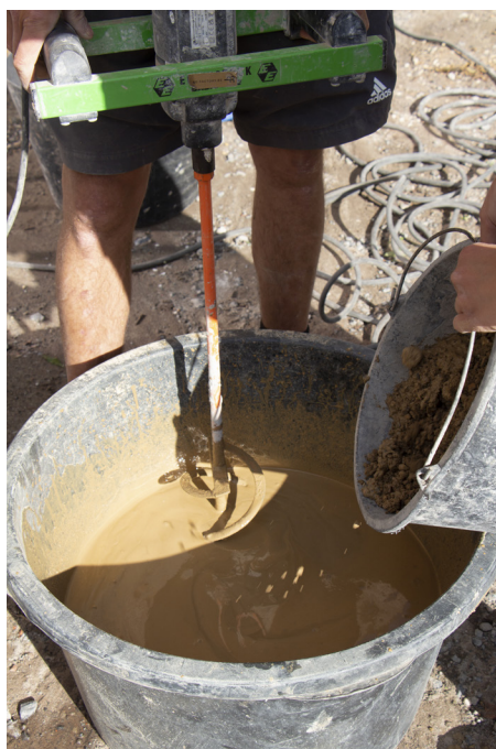
Préparation de la barbotine à l'aide d'un mélangeur de peinture
