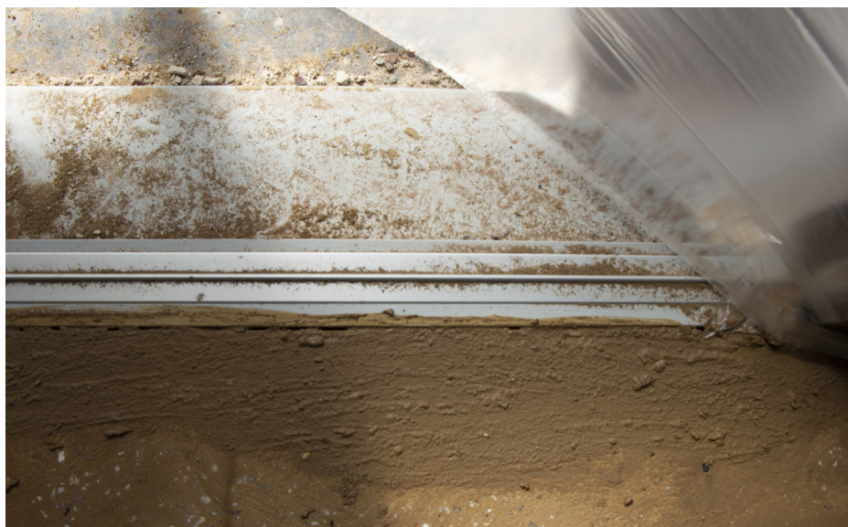
Application de la barbotine à la main sur les zones périphériques
