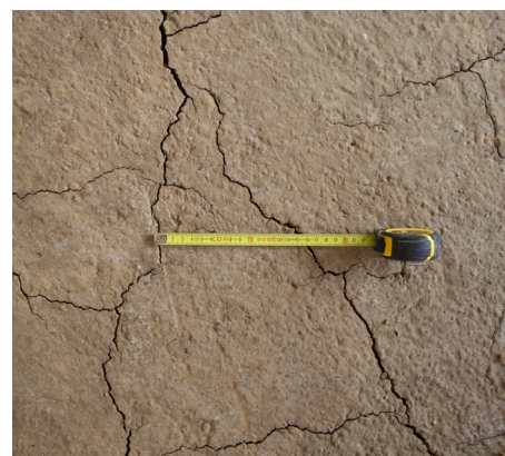
Mesure et contrôle des fissures
