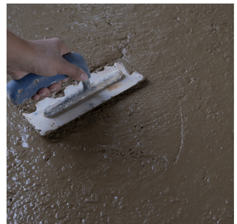
Lissage de la surface de la chape
