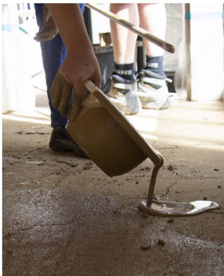
Versement de la barbotine dans les fissures
