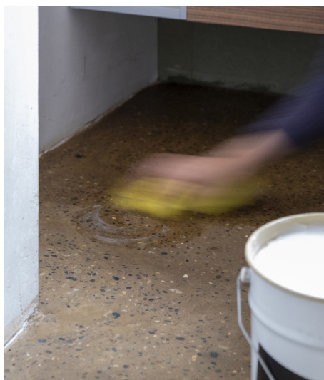
Application de la cire par des mouvements circulaire à l'aide d'un tissu non abrasif
