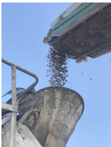
Remplissage du camion malaxeur ou des bigbags avec la Chape en Terre de Léém sèche
